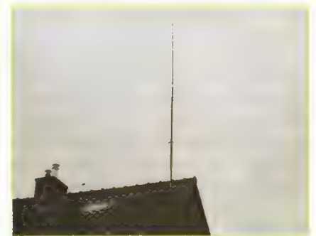
Een enkele antenne, helemaal vrijstaand. Hier met een draadantenne eronder. Een tamelijk ideale situatie.
